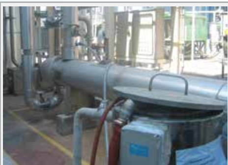
งาน CIP. Cleaning
