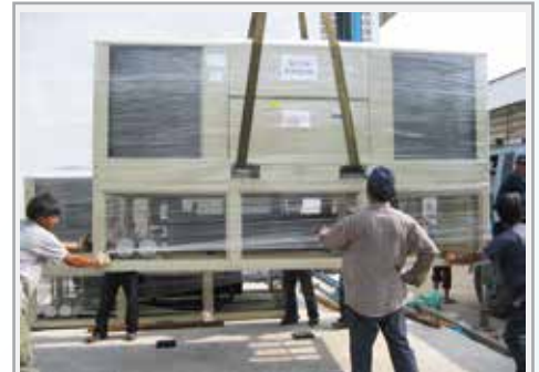
งานติดตั้งเครื่อง Chiller, Heat pump
